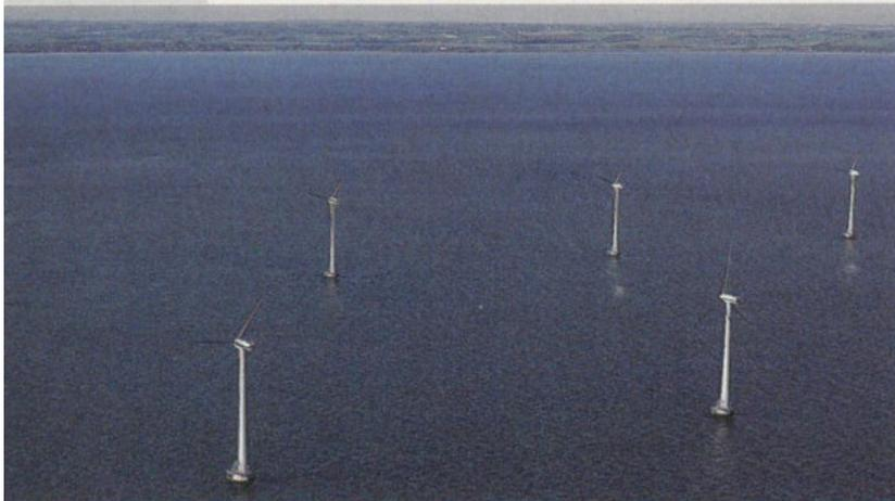
Der Tunø Knob Offshore Windpark an der Ostküste Jütlands wurde im Oktober 1995 an Netz angeschlossen. Er besteht aus 10 Anlagen des Typs Vestas V 39. Das Bild oben zeigt die Aufbauarbeiten mit Hilfe eines Pontonkrans. Fotos: Vestas A/S
